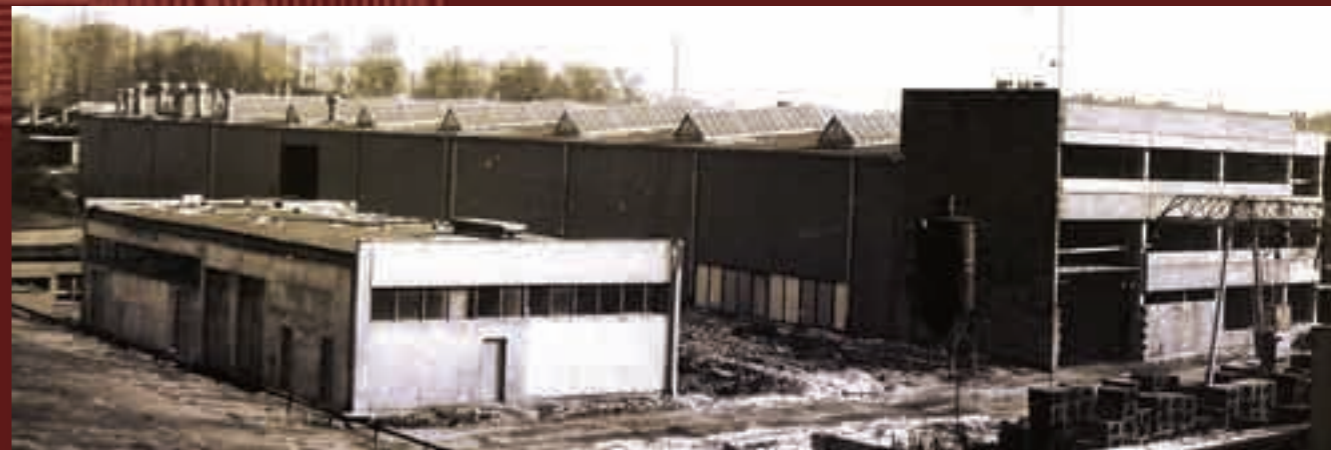
Budowa biurowca przy Hali P2
