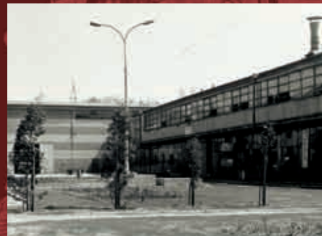
Hala nr 6 i Magazyn Zbytu, 1972 r.
