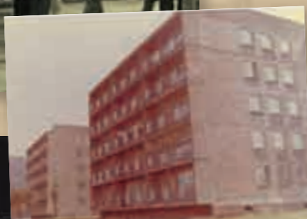
Bloki mieszkalne „Damel-u” wybudowane w latach 1973-78
