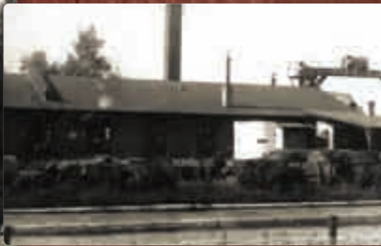
Zabudowania Zakładu w Dąbrowie Górniczej przy ul. Florowskiej 43
